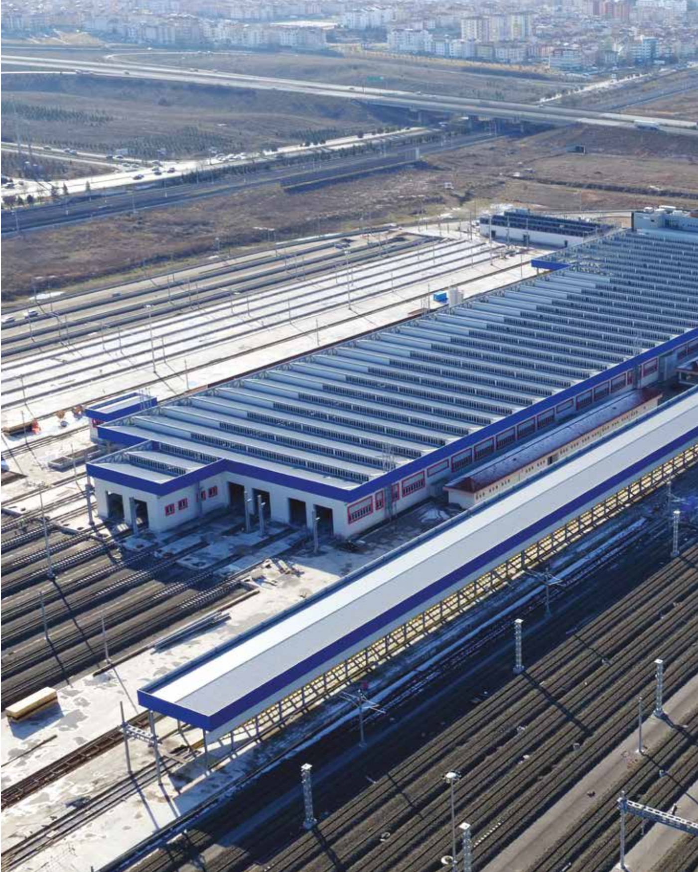
Gülermak - Kolin YHT Gar Kompleksi Projesi Ankara / Taşyünü Çatı ve Cephe Paneli
