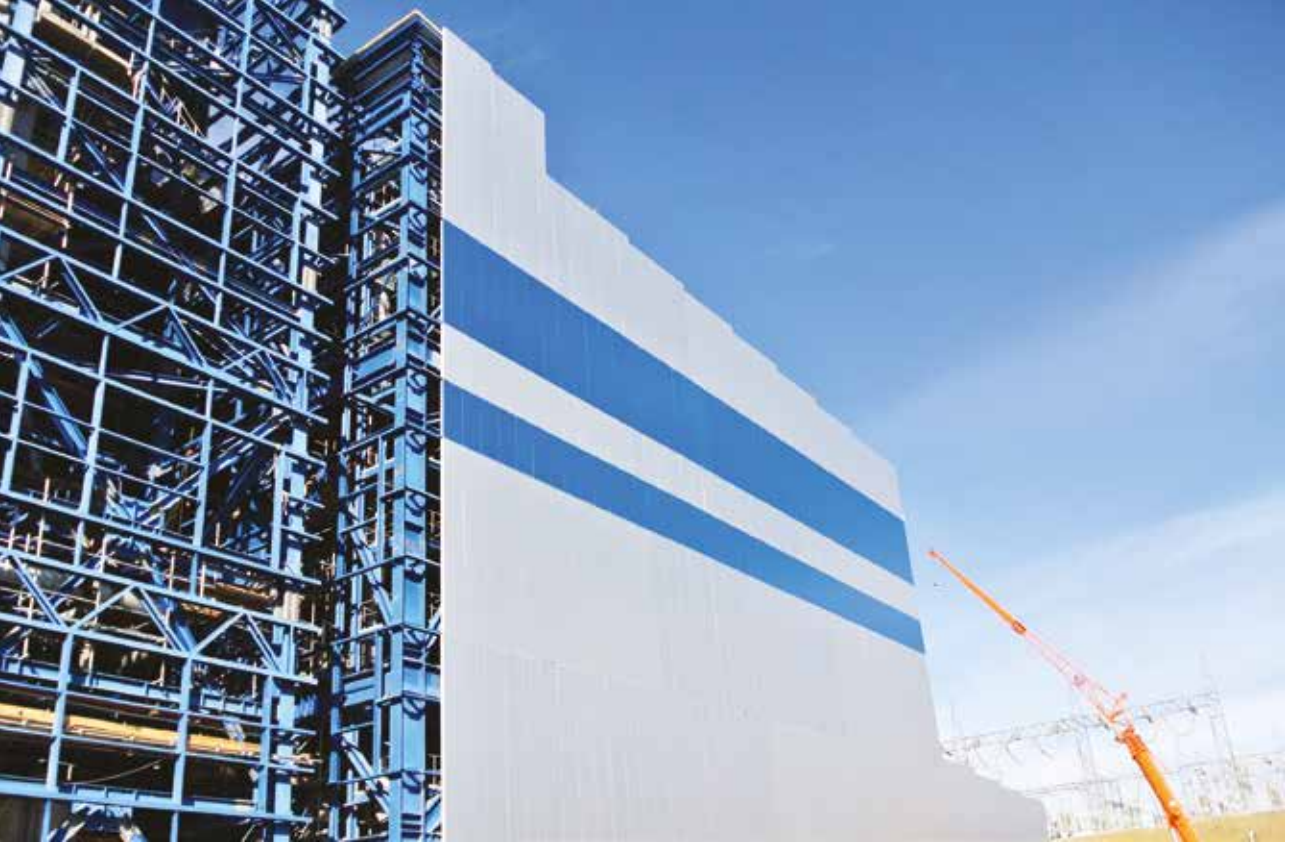
EnerjiSA Tufanbeyli Termik Santral - Adana / Taşyünü Çatı ve Cephe Paneli
