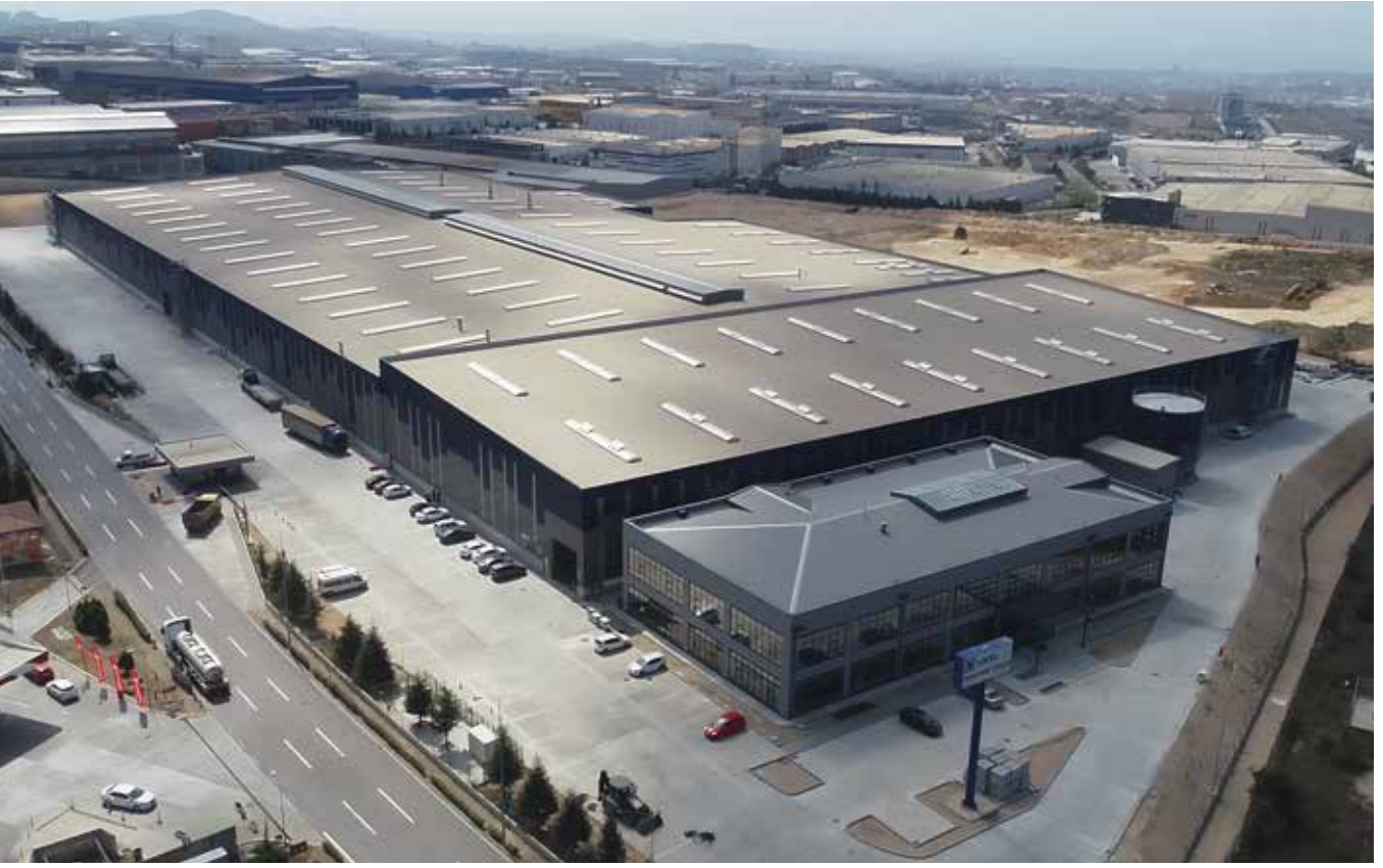
Yücel Boru ve Profil Endüstrisi A.Ş./ Hassas Boru Tesisi - Kocaeli
